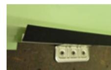
Nastro adesivo impermeabilizzante EPDM.
